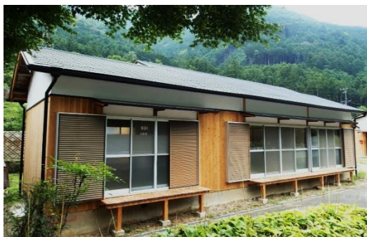
建物の1つ。内装の壁を塗り直します
